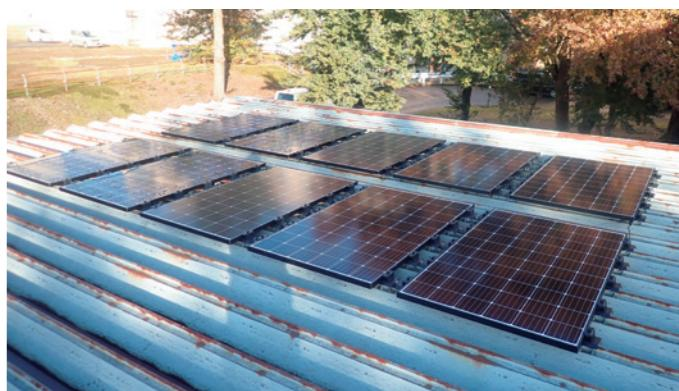
金属折板屋根に設置した高耐荷重の太陽電池パネル
