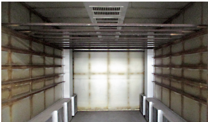
今回診断した乾燥炉の内部
